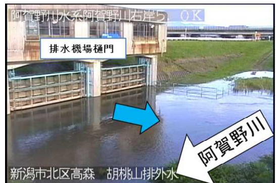
(警戒体制) 排水ポンプ稼働のため樋門全開 (7月31日 17時 撮影)
