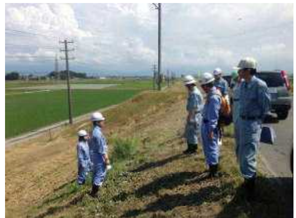
平成26年の点検時の状況
