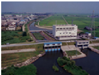
胡桃山排水機場
