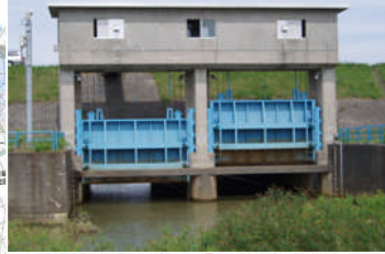
古川樋門 (阿賀野川から望む)
