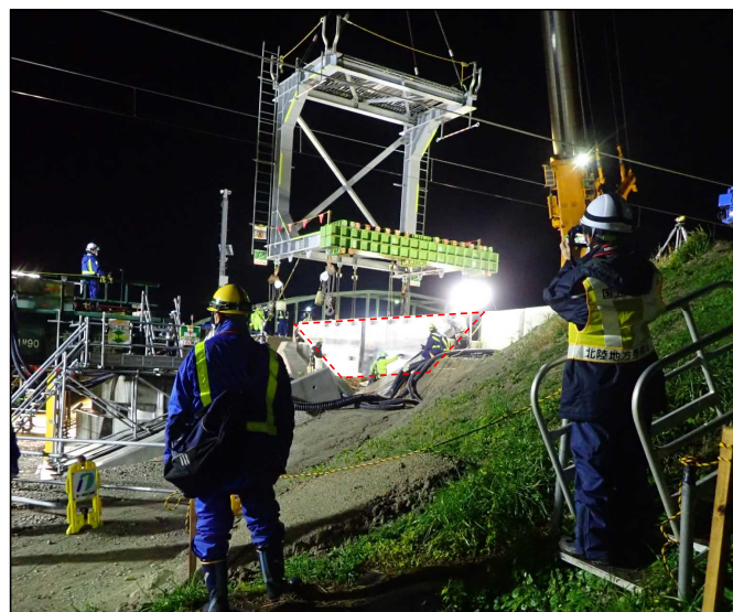
②特殊堤(鋼板)設置
