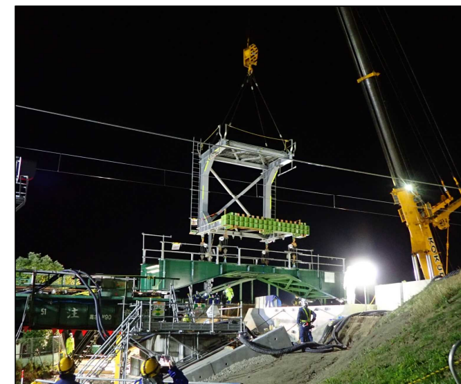
③新橋桁設置
