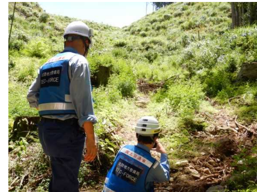
沢見地区 現地状況 (土石流危険溪流被害状況把握)
