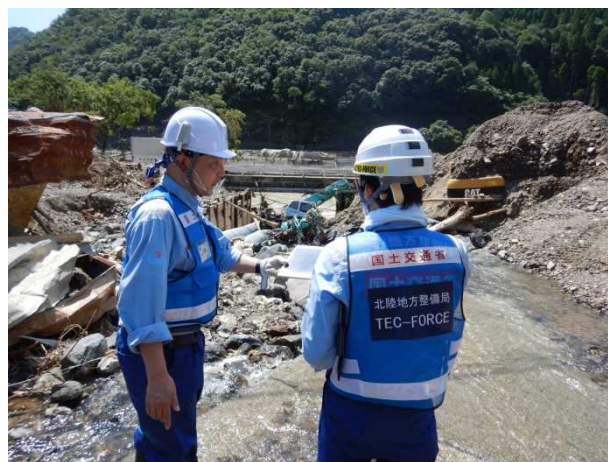
伊高瀬地区 現地状況 (土石流家屋・道路への流出状況確認)
