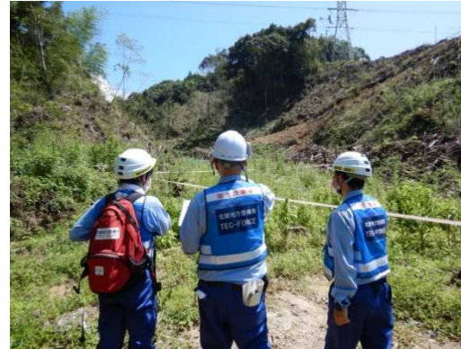
一丸地先 現地状況 (砂利流出状況確認)
