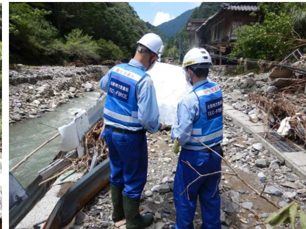
浦野地区 現地状況 (道路寸断状況把握)
