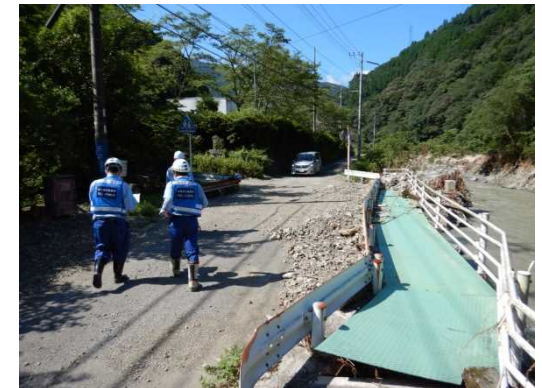
屋形地先 現地状況 (河川洪水による集落の被災状況把握)
