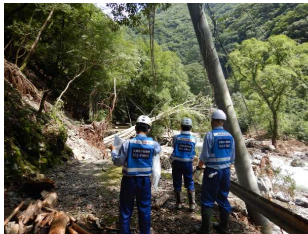
境目地区 現地状況 (道路寸断状況確認)
