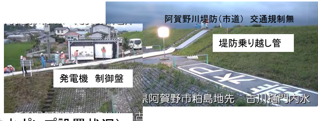
内水側(排水ポンプ設置状況)
