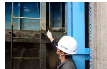
樋門ゲート 扉体点検
