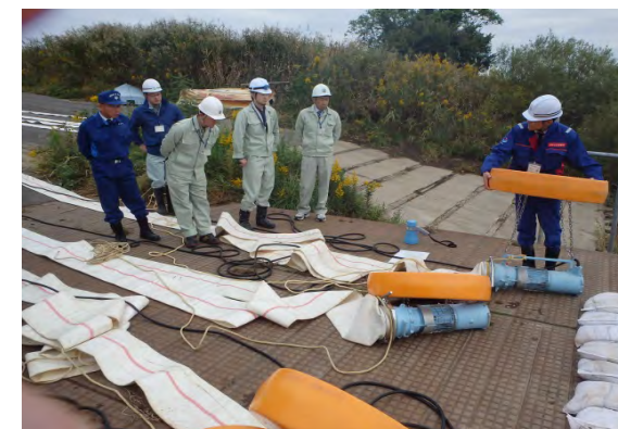
排水ポンプ 設置状況
