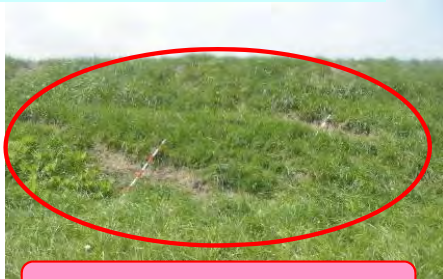
堤防の変状の早期発見
