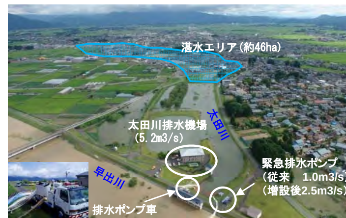
平成23年7月新潟・福島豪雨での出水状況
