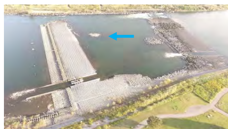
上流側：沢海第二床固（S27年度設置） 下流側：沢海第一床固（S4年度設置）
