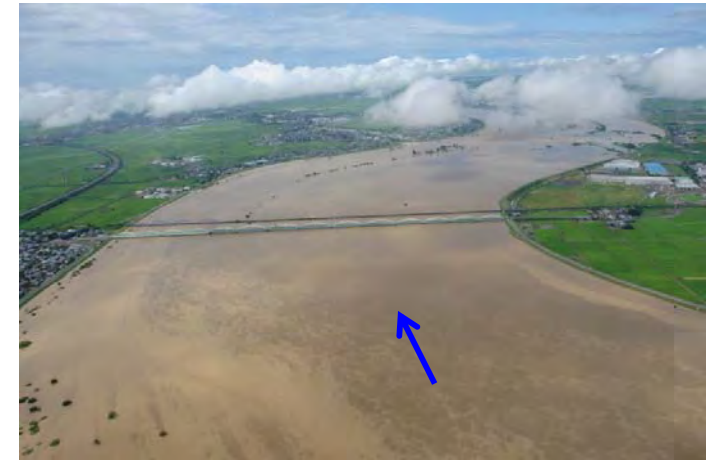
平成23年7月洪水の状況(阿賀浦橋上流から下流を望む)
