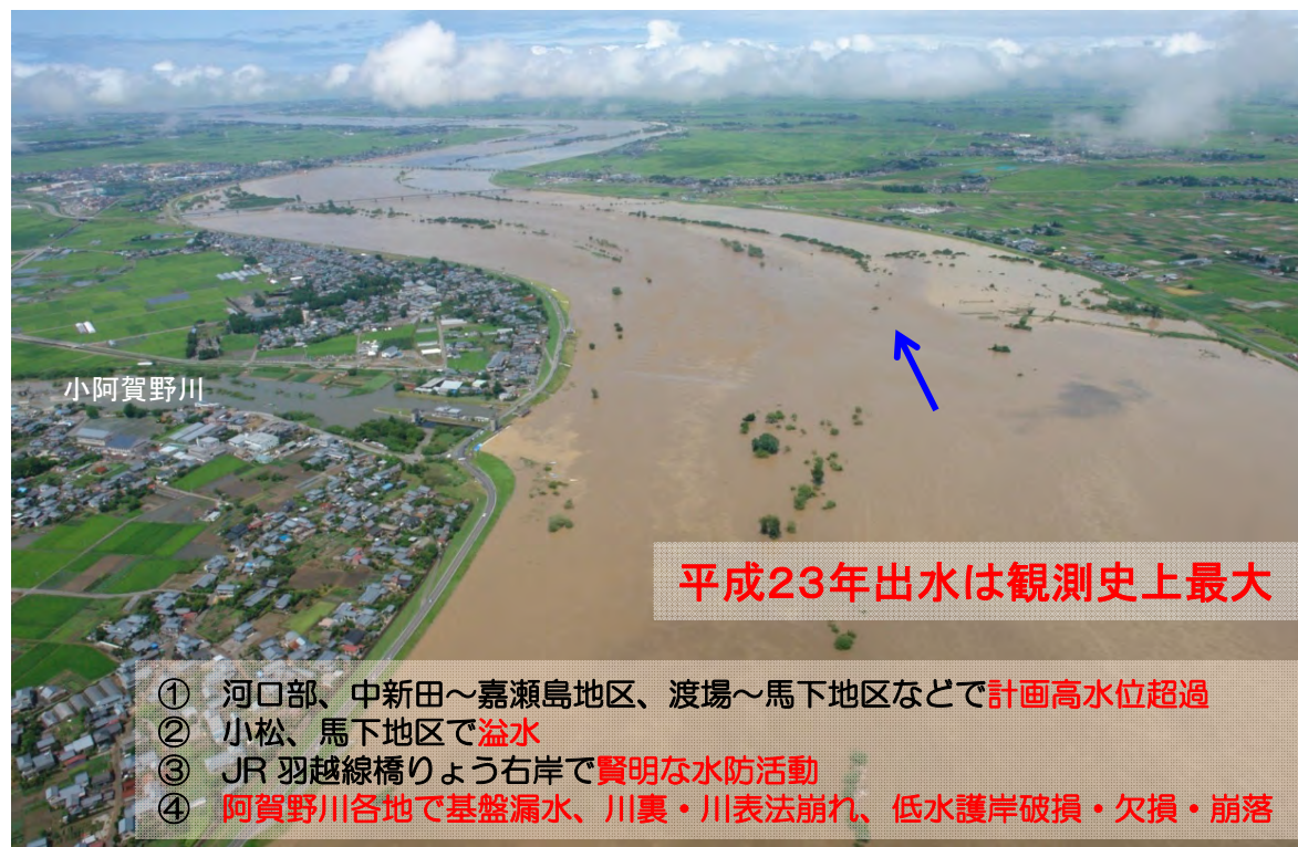
平成23年7月洪水の状況(沢海付近上空から下流を望む)
