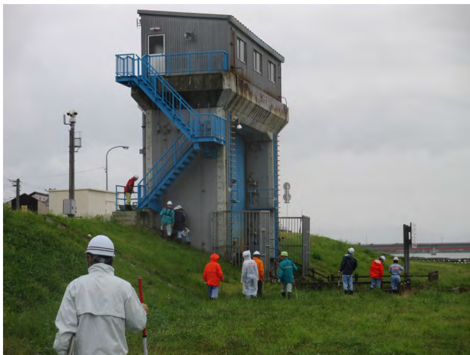
阿賀野川右岸 新井郷川水門付近 護岸の点検 (新潟市北区)
