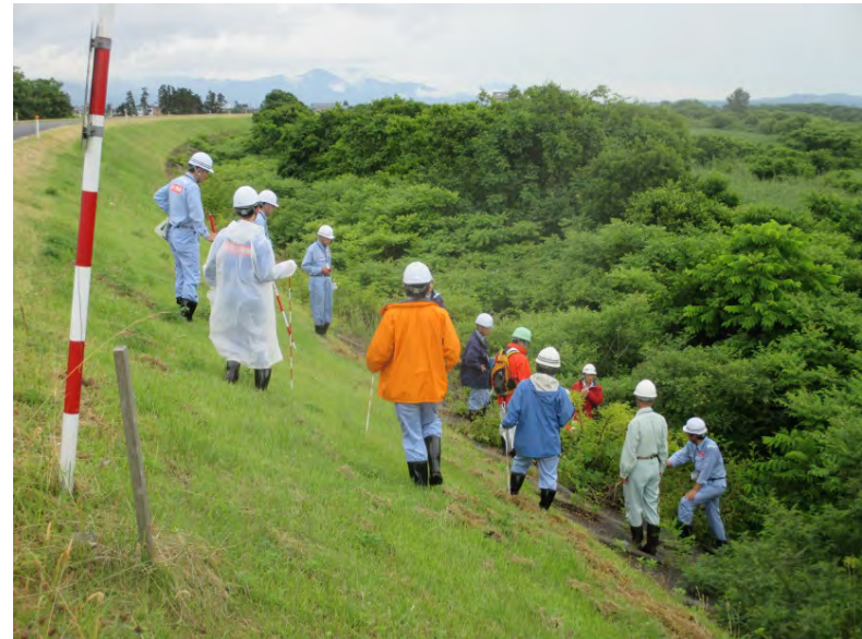
堤防を保護する高水護岸への樹木繁茂 (右岸・写真中央)新潟市北区付近
