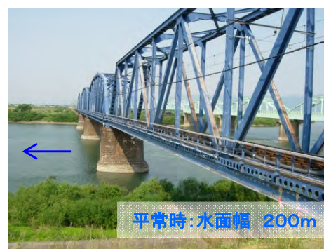
平常時の阿賀野川橋梁付近(平成27年5月)
