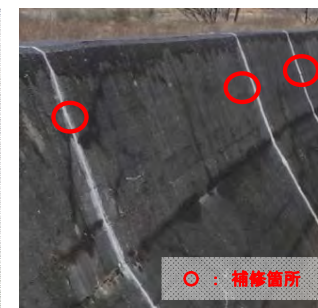
クラック補修後
