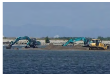
河口部堆積土砂掘削
