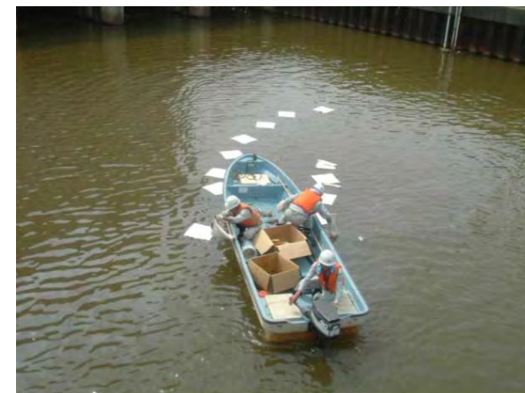
参考写真：水質事故での油除去作業
