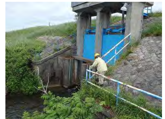
海老漣樋門の点検状況
