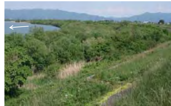
高水敷一面に密生した樹木 （阿賀浦橋上流左岸）
