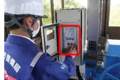
操作訓練では、洪水時に慌てずゲートが開閉操作できるよう実際に樋門・樋管の開閉操作を経験しました。
