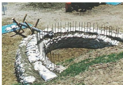
写真 5.41 月の輪工
