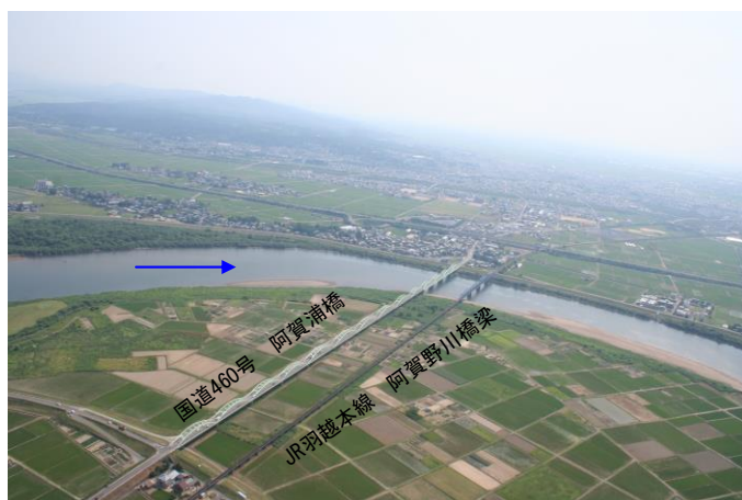
写真 5.3 JR 羽越本線阿賀野川橋梁
