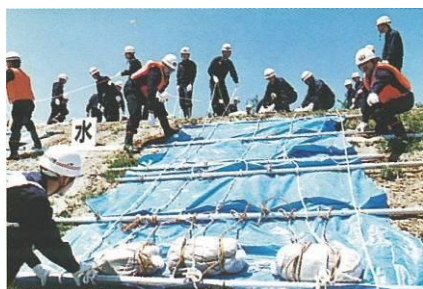
写真 5.40 シート張り工
