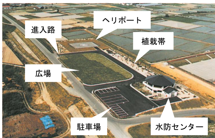
写真 5.34 阿賀野川防災ステーション
