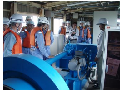
写真 5.25 河川管理施設の点検
