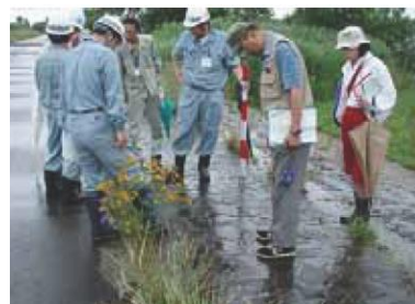
写真 5.28 水辺プラザにおける点検
