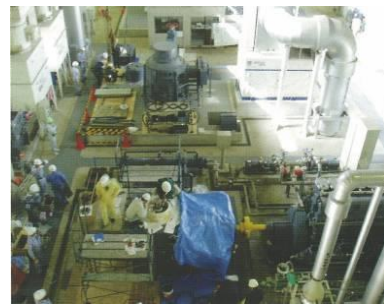
写真 5.26 胡桃山排水機場におけるポンプ点検作業
