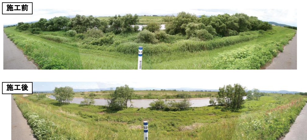
写真 5.8 日橋川 0.2k の樹木伐採の例
