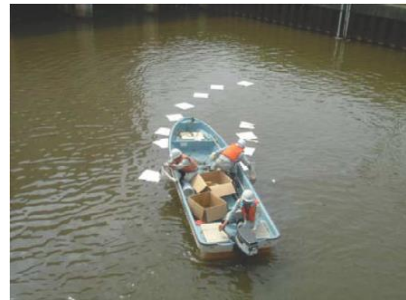
写真 5.33 水質事故での油除去作業の様子
