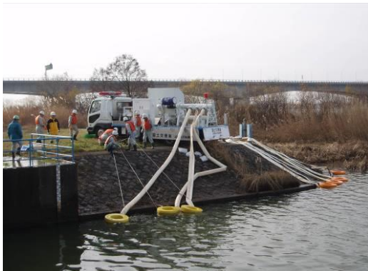
写真 5.4 排水ポンプ車操作訓練
