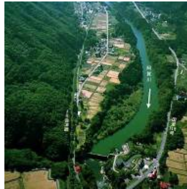
写真 2.1 小谷堰堤付近
