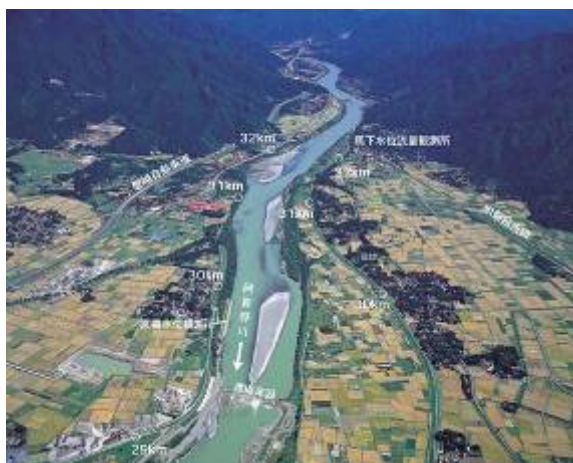
写真 2.6 渡場床固付近(阿賀野川 29k~30k)
