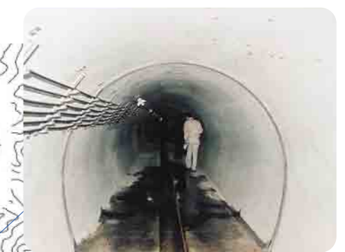
▲袖の沢排水トンネル工
