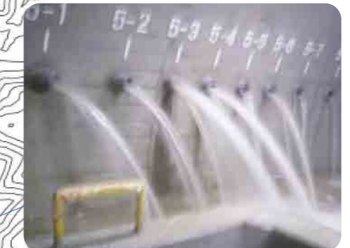
排水トンネル内の集水状況
