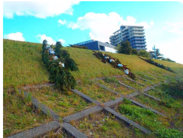
水防技術講習会（木流し工法）
