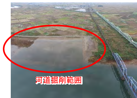
平成28年11月 下里地区 河道掘削 完成写真
