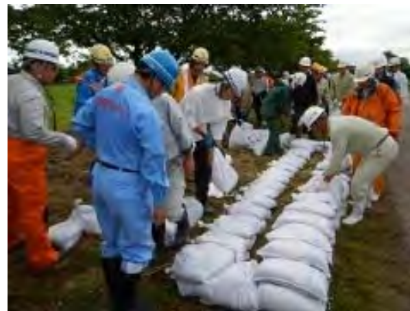
水防工法演習（積み土のう工）
