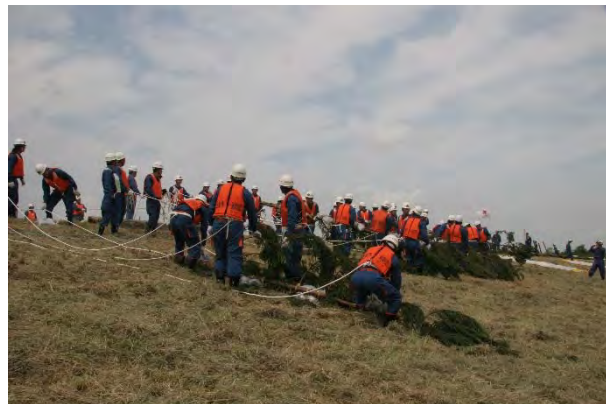
水防訓練 木流し工法(早出川河川敷)
