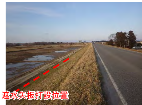
平成29年3月 大迎地区 浸透対策 完成写真
