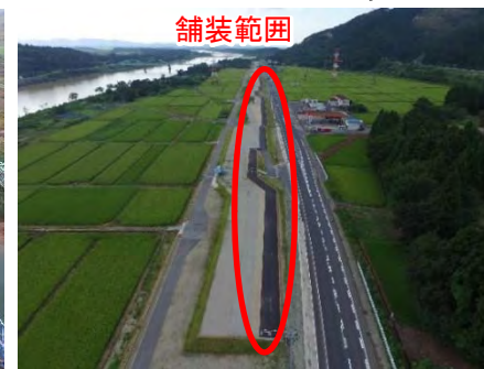
平成28年8月 小松地区 堤防天端保護 完成写真
