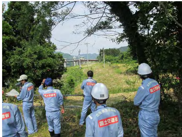
阿賀野川左岸33.6kp(五泉市小松地先)
