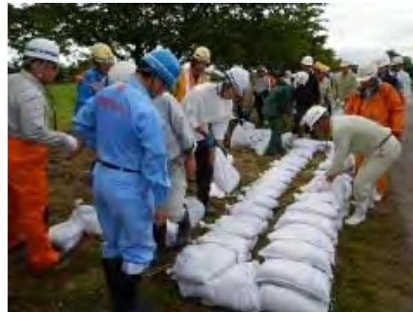
水防工法演習(積み土のう工)
