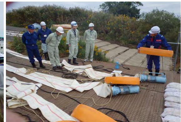
排水ポンプ 設営状況
