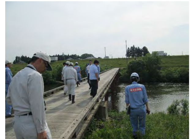
早出川羽下大橋(五泉市羽下地先)
