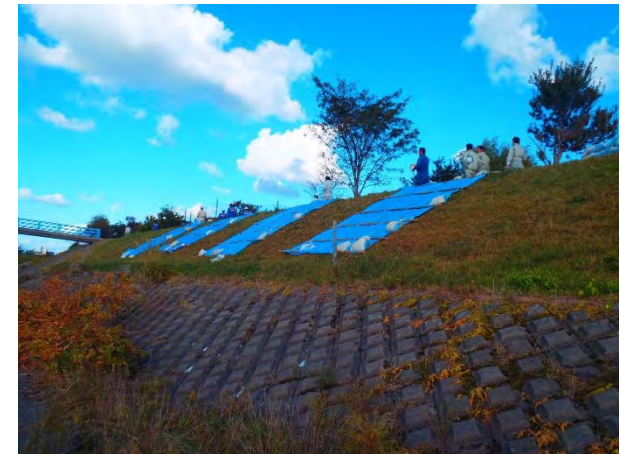
水防技術講習会（シート張り工法）
