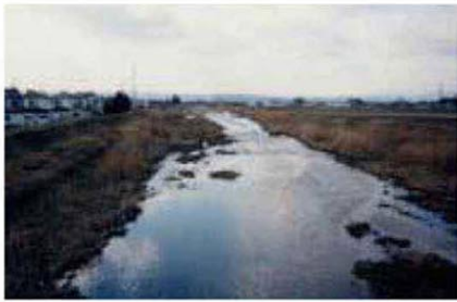
整備前の新湯川 平成11年3月
