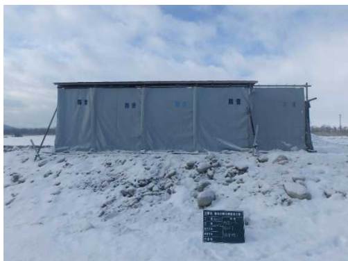
防音シート取付状況
