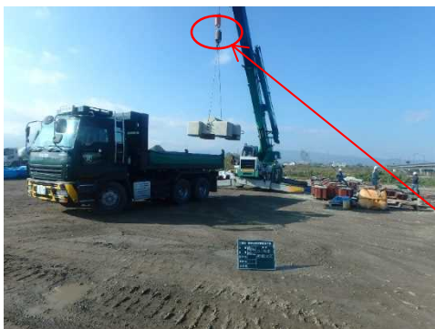
ブロック製作・運搬作業中
