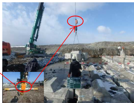
ブロック据付作業中
