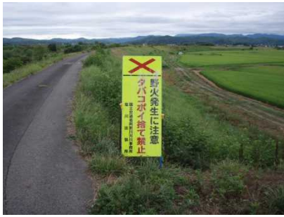
汚染状況 平成 30 年 6 月 7 日 日橋川右岸 1.2 k p 附近 鳥のフン害状況
