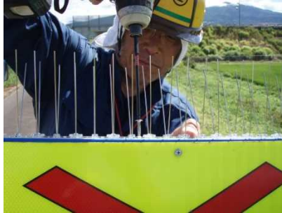
鳥よけシート 取付完了 平成 30 年 8 月 9 日 日橋川左岸 2.6k p 附近
