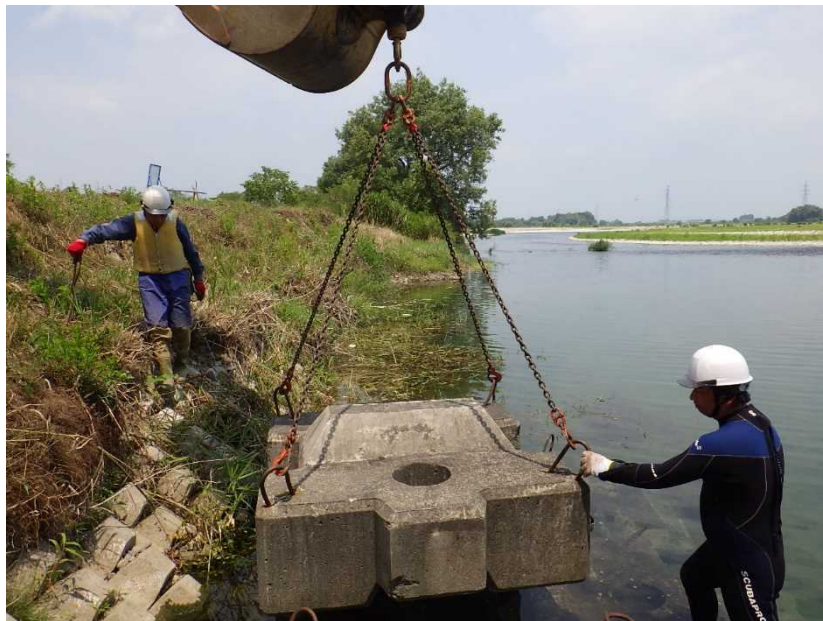
施工状況写真
