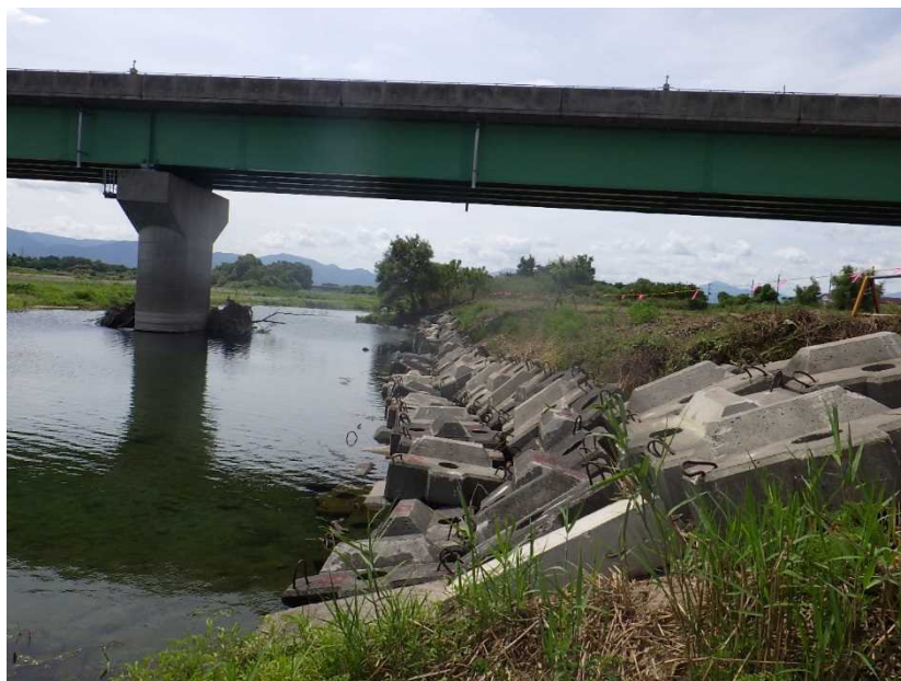
施工完了写真
