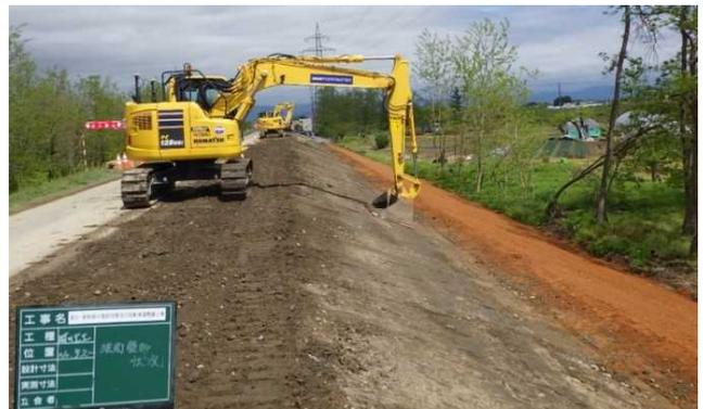
写真-8 ICT建機による衣土施工状況
