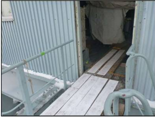
写真 - 5 機械室出入口にテフロン板設置
