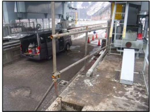
写真 - 1 4 手摺設置
