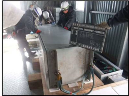
写真 - 6 テフロン板上で制御盤を滑らせ搬出、搬入
