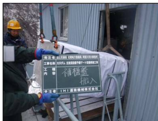
写真 - 4 制御盤を斜め吊りにし機械室内へ搬入
