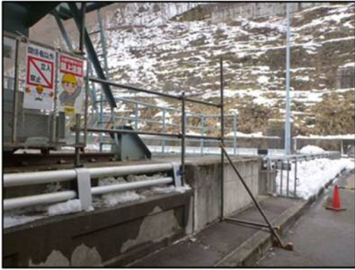
写真 - 1 3 手摺設置
