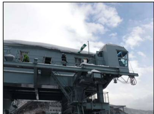
写真 - 9 ガントリークレーン歩廊上に吹流し設置
