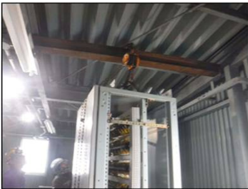
写真 - 7 機械室内建屋・H鋼に架設ビーム取付
