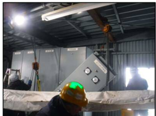
写真 - 8 架設ビームにイーグルクランプ・チェンブロック等を取付け、制御盤を横向に倒す
