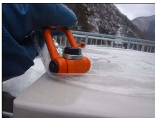
写真 - 3 制御盤上部にマルチアイボルト取付
