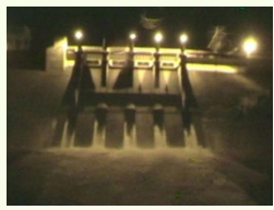
コンクリートからの放流 (平成27年9月10日)
