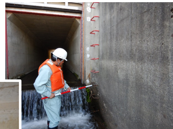
点検足場等付属施設の点検 (大石排水樋管)
