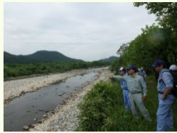
職員による堤防点検
