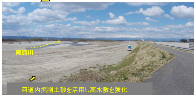
工事の状況 令和2年4月11日撮影
