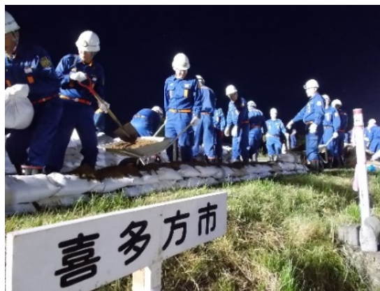
土のう積み工
