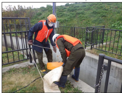
排水ホース接続
