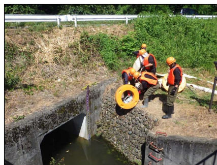
排水ポンプ設置
