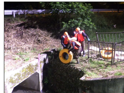
排水ポンプ設置（夜間）
