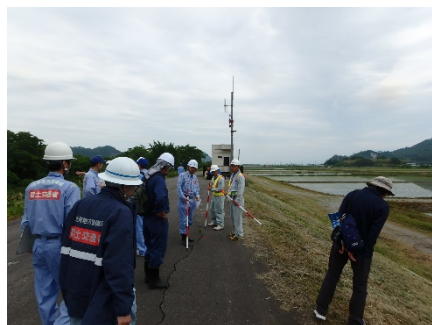
堤防天端舗装クラック
