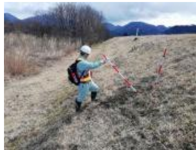
堤防法面損傷状況把握
