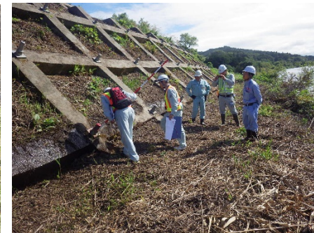
地すべり抑止工状況
