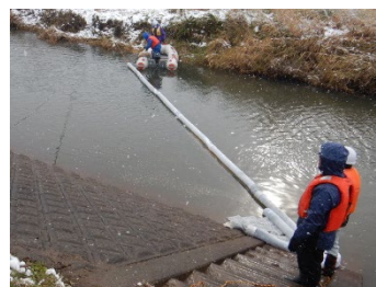
オイルフェンス設置
