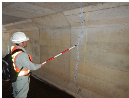
排水樋管等の函体内部の点検 (宇内第一排水樋管)
