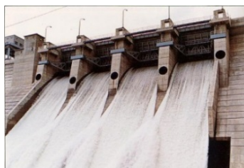
スリットゲートからの放流 (試験湛水時)
