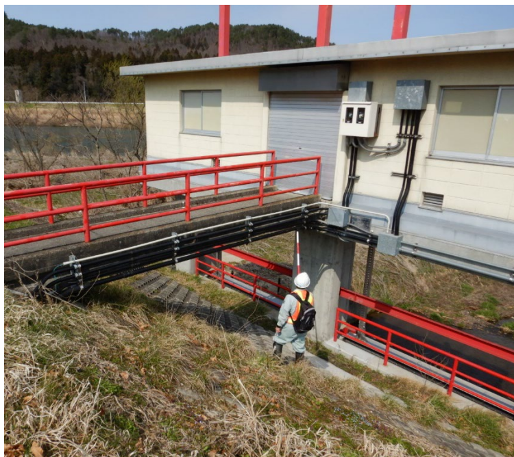
排水樋管等の門柱、翼壁、管理橋等構造物の外観点検 (宇内第一排水樋管)
