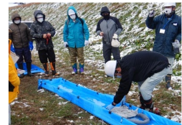
水路での油吸着マット設置
