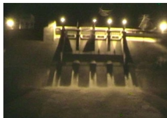
コンジットゲートからの放流 (平成27年9月10日午前2時)
