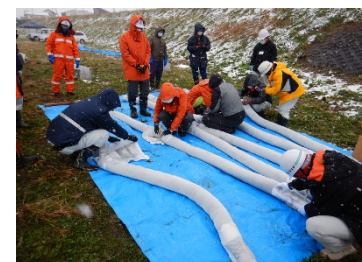
オイルフェンス接続
