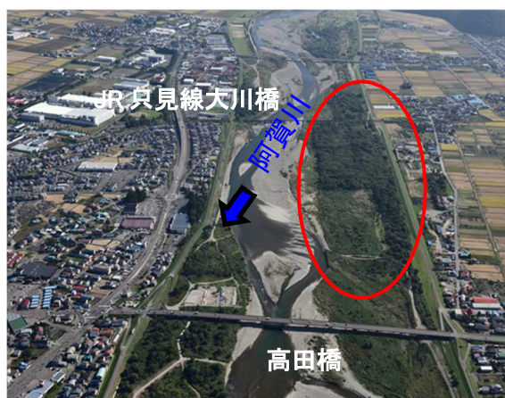
流下能力不足箇所の事例 会津若松市上米塚地先
