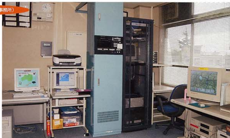
▲県中建設事務所
