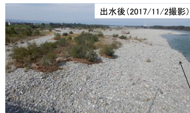
出水時・出水後の河道状況(高田橋下流、23.0k付近)
