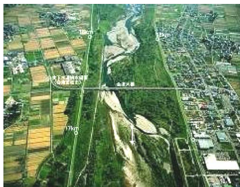
写真1.1 会津大橋付近(阿賀川17k～18k)
