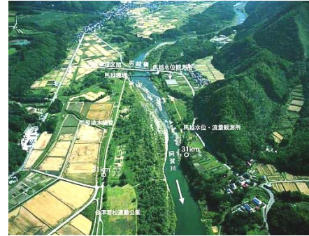
写真 2.7 馬越頭首工付近
