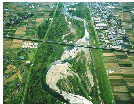
写真 2.5 磐越自動車道阿賀川橋付近
