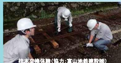
枕木交換体験(協力:富山地铁建設㈱)
