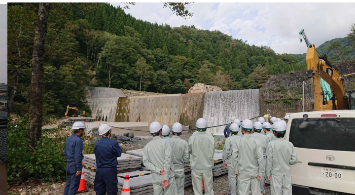
金沢工業大学 環境土木工学科 (白峰砂防堰堤 白峰砂防出張所)
