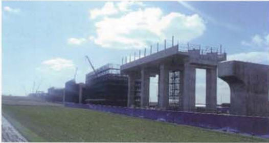
(金沢・敦賀延伸に向けた建設現場)
