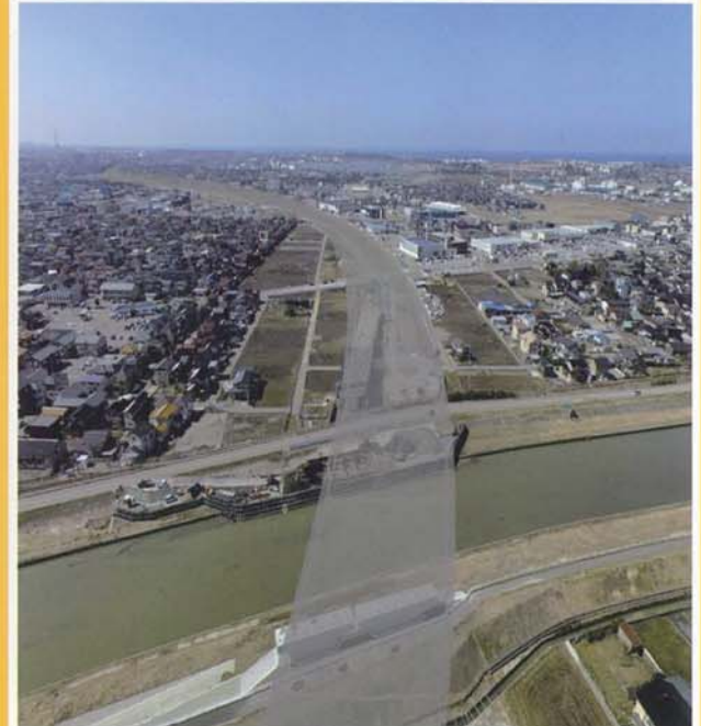
※写真中は建設ルート (建設中の現場)
