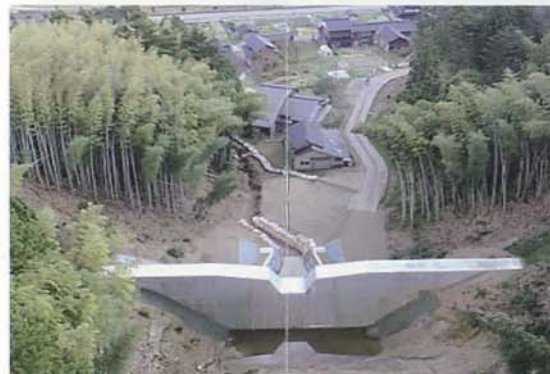
(工事実施後のがけ地)
