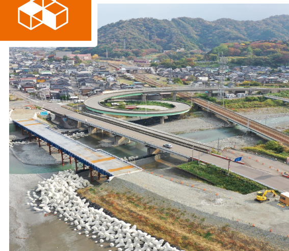
[一般国道8号 糸魚川地区橋梁架替Ⅱ]
