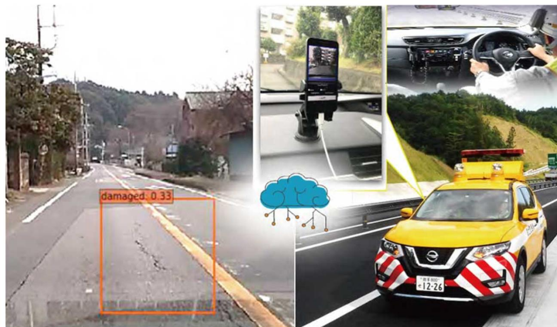
舗装の損傷を自動検知
