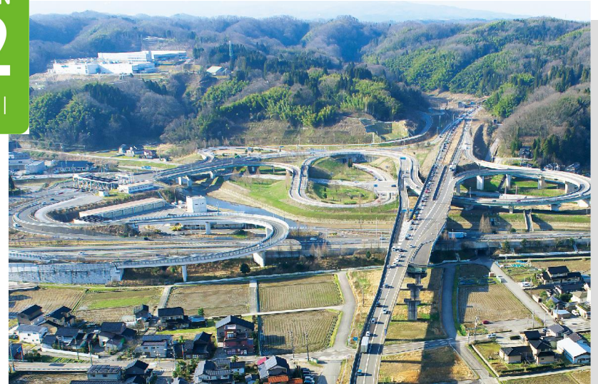
〔国道159号 金沢東部環状道路〕
