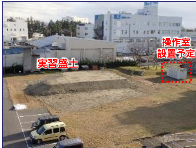
高さ2mの実習盛土を設置
