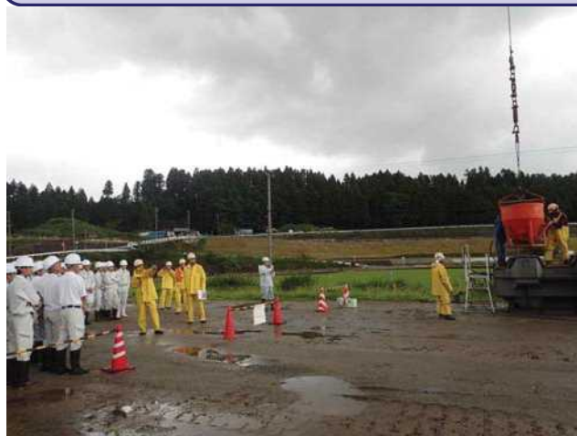
コンクリート打設状況視察
