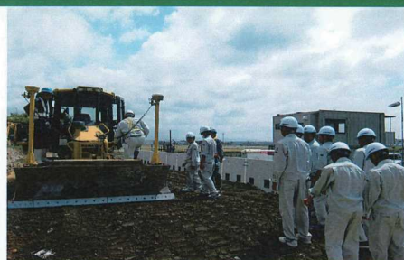
☆小松バイパス大長野 県立翠星高校 国土交通省北陸地方整備局 金沢河川国道事務所
