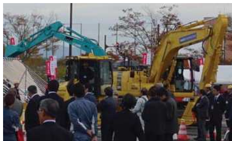
ICT建設機械による施工実演状況
