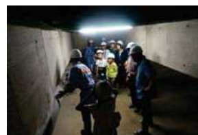
免震構造 見学
