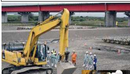
ICT土工の説明を受ける様子
